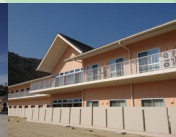
やまびこ寮 建替工事完成
